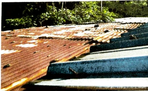
Foto 5: Sustrucción de lamina, por lamina troquelada Aluzinc en el tercer modulo.
