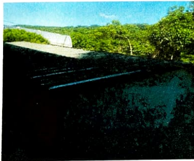
Foto 3: Sustrucción de lamina, por lamina troquelada Aluzinc en el segundo modulo.
