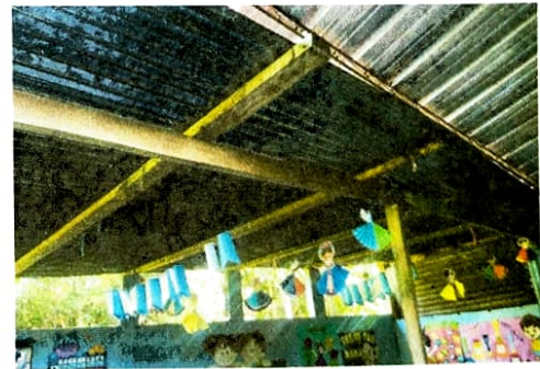
Foto 6: Sustrucción de estructura de soporte de madera por costanera GLV 4X2 "16" en el tercer modulo
