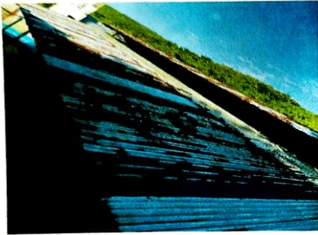
Foto 1: Sustrucción de lamina, por lamina troquelada aluzinc en el modulo 1
