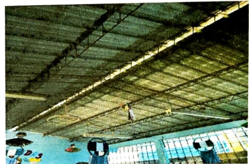
Foto 4: Mantenimiento a estructura de soporte de metal. En el segundo modulo
